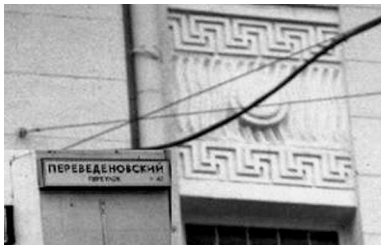
Фасад дома на Переведеновском переулке
